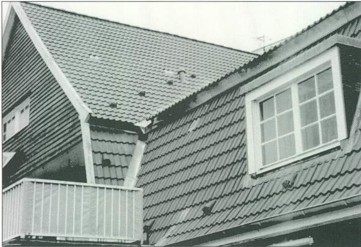
Das fertige Dach mit einem kpl. neu verkleideten Erker
