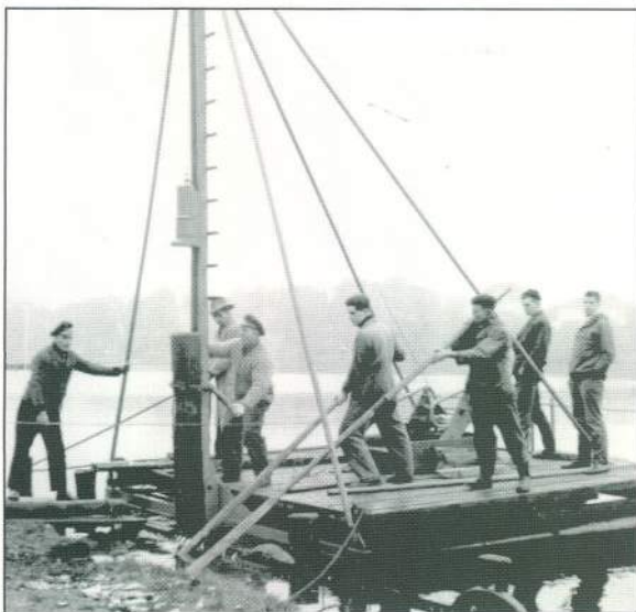
1963 wurde von Willi Werner und Helmut Schneider diese Ramme gebaut, wie man sieht, mußte immer wieder das Bohlwerk erneuert werden. Eine schwere Knochenarbeit, die Fahrten mit den Booten hatten vorab genau so viele Arbeitsstunden.
