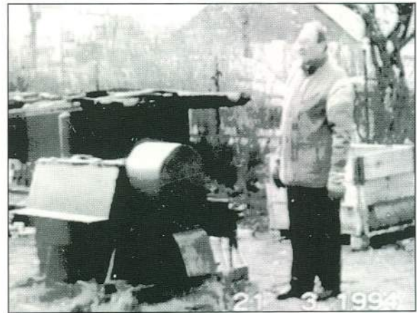
W.Röttger zieht mit der Winde, die mit der Ramme heraus gezogenen Pfähle an Land UNTEN: Der Hafenbaubagger setzt die Spundwand
