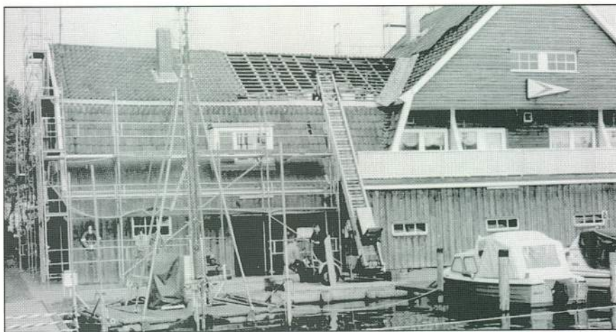
Beim Abdecken und der Neuverlegung waren viele Dachdecker tätig
