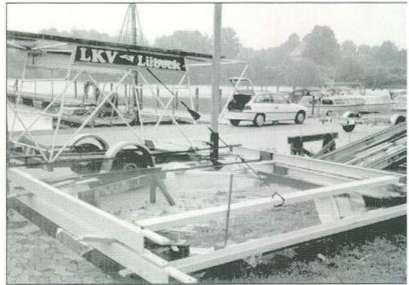
Die seitlichen Stützen werden auf dem Kopffahmen rechteckig hergerichtet
