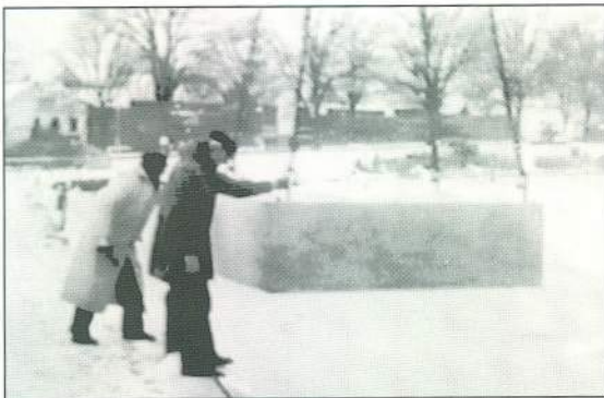
Der auf Maß ins Eis gesetzte Betonschwimmer lag somit für die Endmontage genau fixiert
