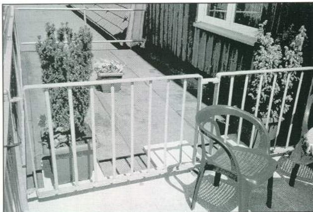
Das Geländer wurde am Plattenende wieder eingesetzt
