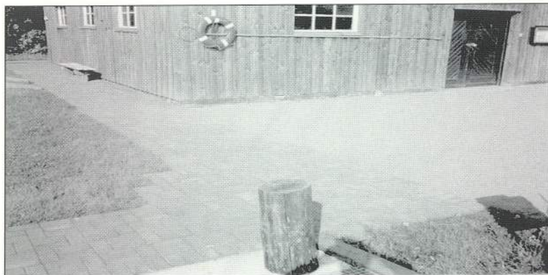
Der Übergang zum Fußweg ist einwandfrei. Toni Boehm verlegte nachträglich noch Steine bis an die aus Stahlbeton erstellte Brückenbefestigung
