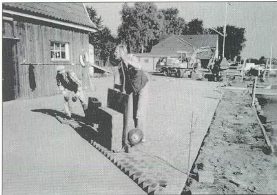
Die Steine wurden sehr zügig verlegt
