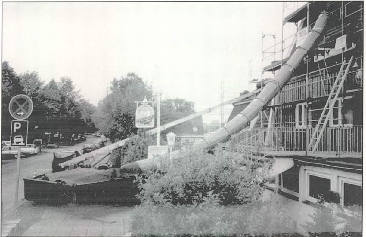
Fast staubfrei und umweltgerecht wurden die Pfannen entsorgt
