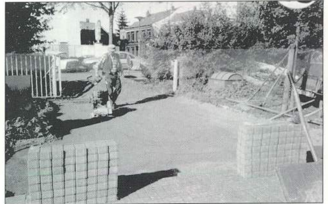
Der Boden wurde ca 20 bis 25 cm tief ausgekoffert und mit einem Rüttler verdichtet
