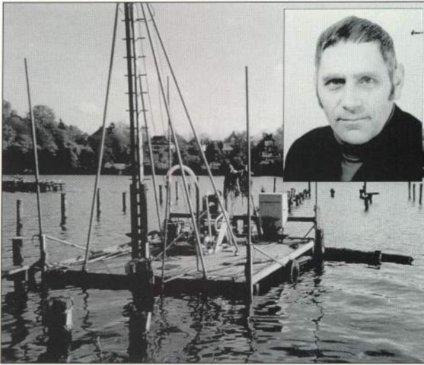
Die Schwimmramme wurde 1963 von Willi Werner und Helmut Schneider gebaut, 1989 von Helmut general überholt und die Fallhöhe der Rammbirne verlängert
