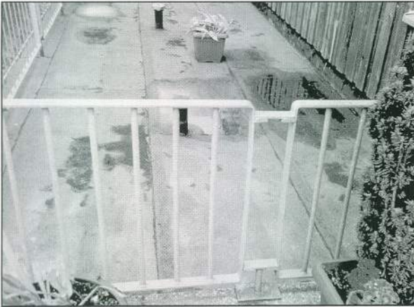
Das Gitter wurde um zwei Meter versetzt ein Kalk – Zementgemisch verlegt worden. Die Übergangsplatten wurden mit Dachpappenstücke angehoben.
