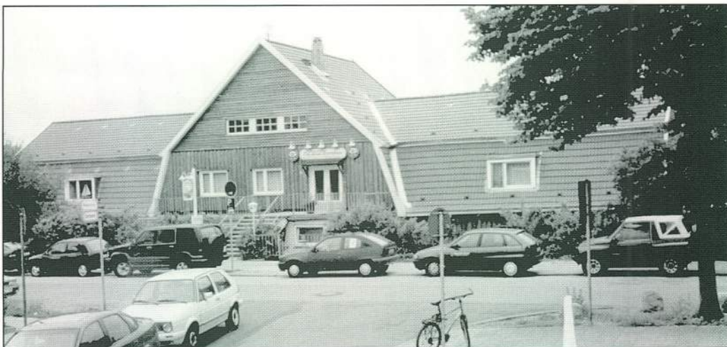
Die neue Bootshausansicht von der Straßenseite
