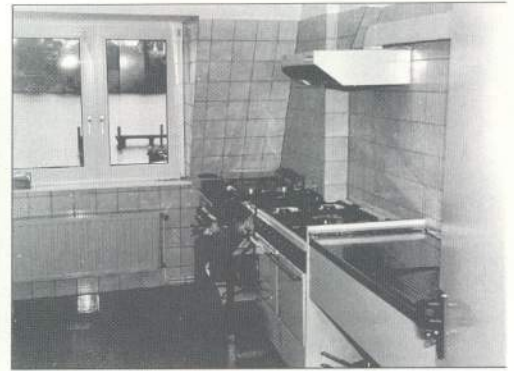
Die gesamte Kücheneinrichtung neu eingebaut. Die Stromversorgung neu verlegt
