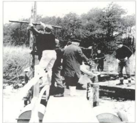
Brückenarbeiten im Frühjahr
