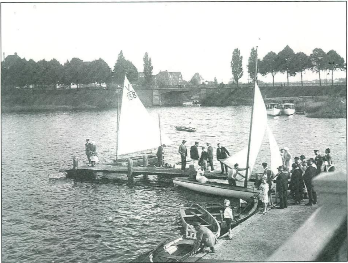
Die erste Anlegebrücke des LKV, auch das Bohlwerk ist neu - 1925 Rechts im Hintergrund war die Brücke für Bogaskes Fahrgastschiffe.
