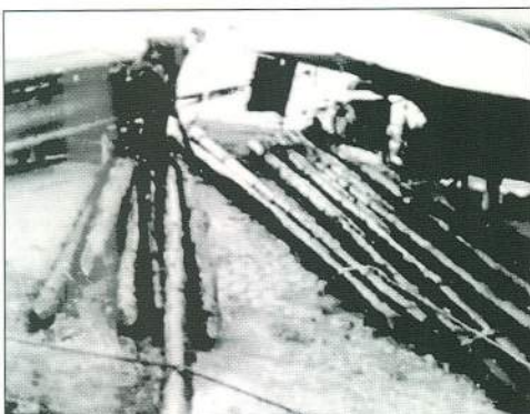
Beim Abbruch der alten Brückenanlage, auf der Ramme H. Schneider u. G. Röttger, eine schwere Arbeit UNTEN: Die an Land gezogenen Pfähle
