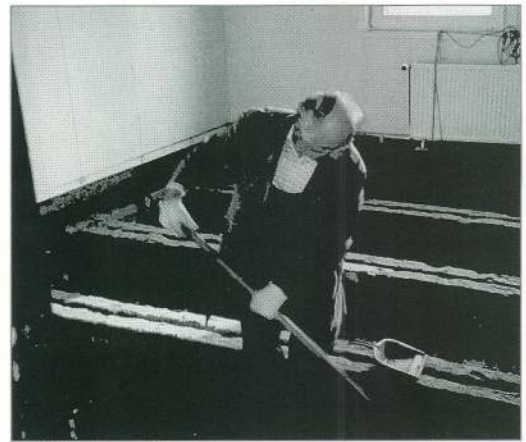
In zwei Räumen legten wir, für den schon mürben Holzfußboden, 15 cm starke Gasbetonplatten
