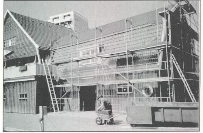
Der Container für die alten Pfannen wurde auf Bohlen abgesetzt
