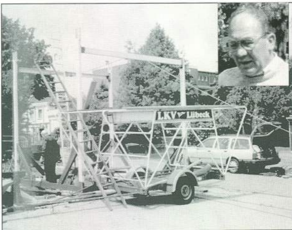
Die fertig geschweißten Stützen richteten wir mit der Winde auf, das Seil wurde über einen Fußblock umgelenkt Wolfgang Röttger unser Malermeister oben rechts i. Bild
