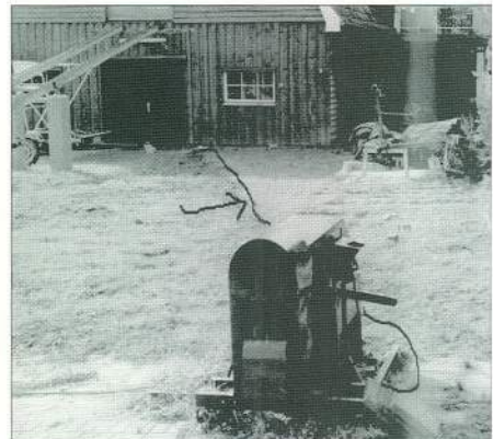
Die Slipwinde bekam 1995 einen Erdkabelanschluß
