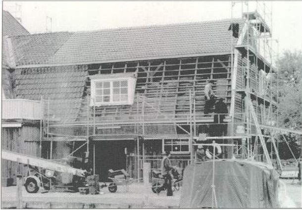
Abschnittsweise wurden die Pfannen ausgewechselt
