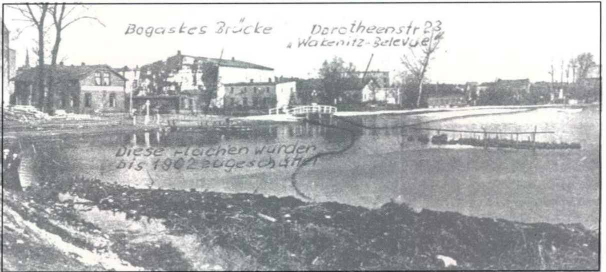
Der Dükerkanal wurde zwischen 1895 und 1900 beim Elbe – Lübeck Kanalbau erstellt. Er versorgt, durch ein unter dem Kanal liegendem Dükerrohr, den Krähen – und Mühlenteich wie vorher auch, mit Wakenitzwasser.
