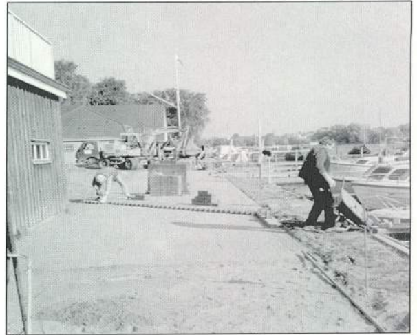
Vom 12. bis zum 30.09.94 dauerten Pflasterarbeiten der Fa. Höppner
