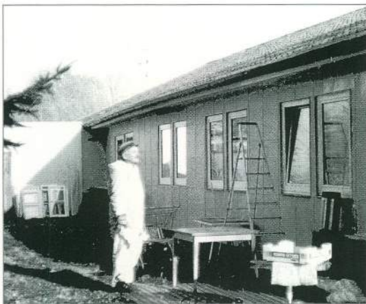
Kunststofffenster mit Isolierglas wurden für die alten Holzprossenfenster eingesetzt
