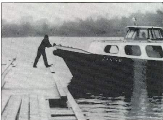
Der Zander drückt die beiden je 15 Tonnen schweren Schwimmbrücken an die Pfähle. Ohne diese Hilfe hätten wir, bei dem starken Ostwind, die Brücken nicht an die Pfähle bekommen
